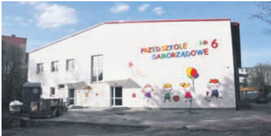
W budynku przy ulicy Armii Krajowej trwają obecnie prace wykończeniowe.
